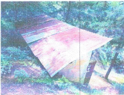
Foto 3: sustitucion de laminas
