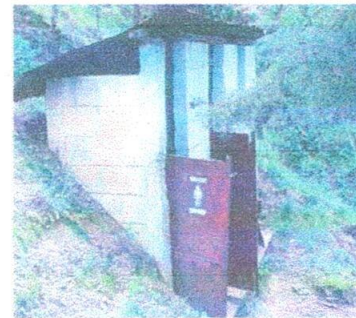
Foto 4: sustitución de puertas, repello y pintura de paredes interior y exterior
