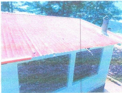
Foto 9: Reparacion de canales
